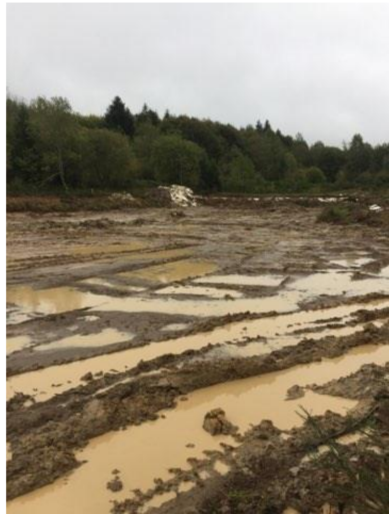
Travaux sur Plombières avec Nature et Techniques
